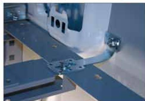
Verifier le serrage des points de fixation à la clé dynamométrique (M6 = 0,75daN.m - M8 = 1,78daN.m)
