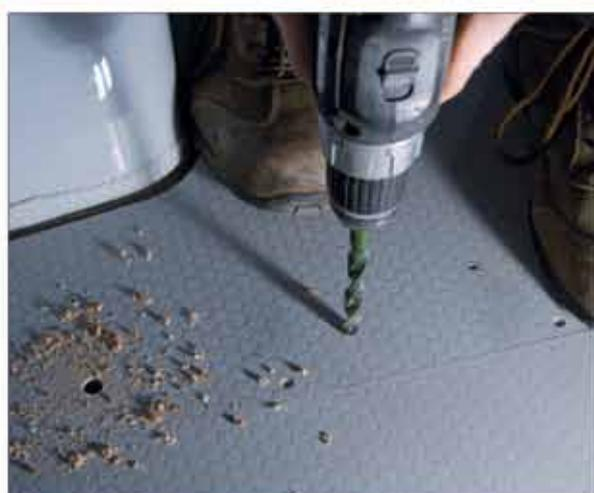
Percer le plancher avec un foret de 11mm et utiliser les inserts bois taraudés.
